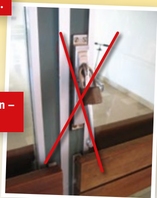
Wegen der fixierten Tür verteilt sich der Rauch im ganzen Stockwerk.
