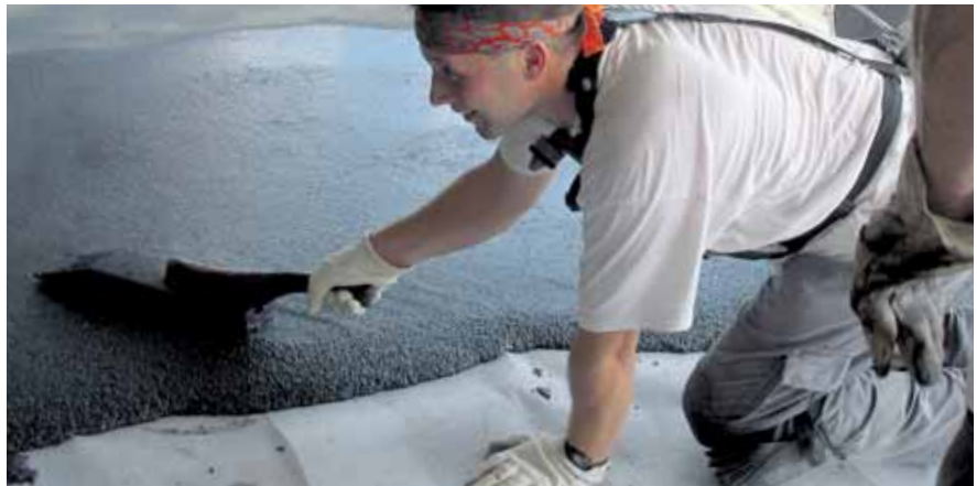
Einbau von Gussasphalt-Estrich
