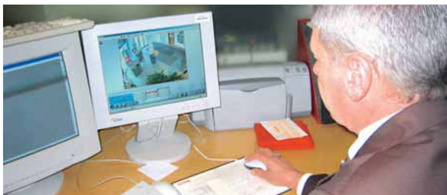
Bild 4: Aufschaltung der Videoüberwachung verschiedener Geschäftsstellen auf eine Leitstelle
