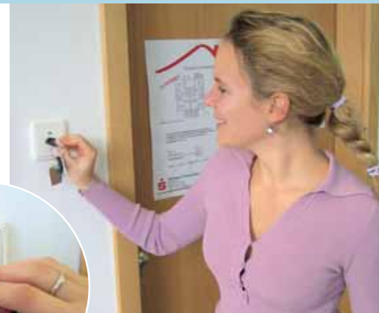
Bild 2 und 3: Unscharfschaltung des Personaleingangs mit elektronischem Schlüssel
