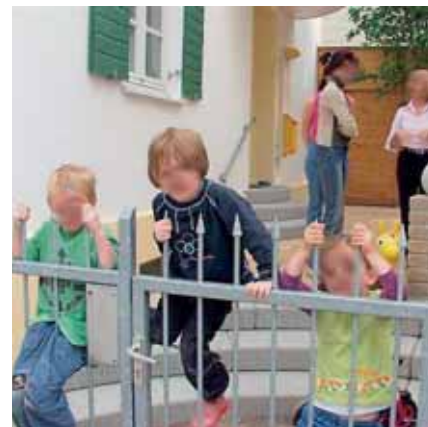
Bild 6: Stahlzaun ► Gefährliche Spitzen
