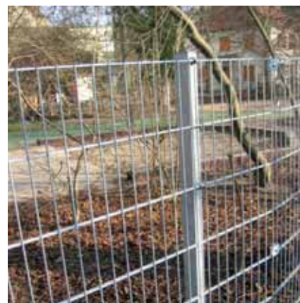
Bild 1 und 2: Stabgitterzaun ► keine Gefährdung, abgeschirmte Enden
