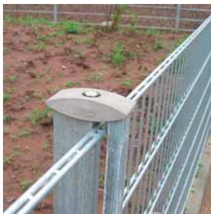
Bild 1 und 2: Stabgitterzaun ► keine Gefährdung, abgeschirmte Enden
