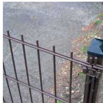
Bild 3 und 4: Stabgitterzaun ► Gefährdung durch hervorstehende, offene Enden
