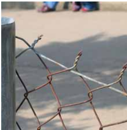
Bild 7: Maschendrahtzaun ► Gefährdung durch hervorgebogene, offene Enden
