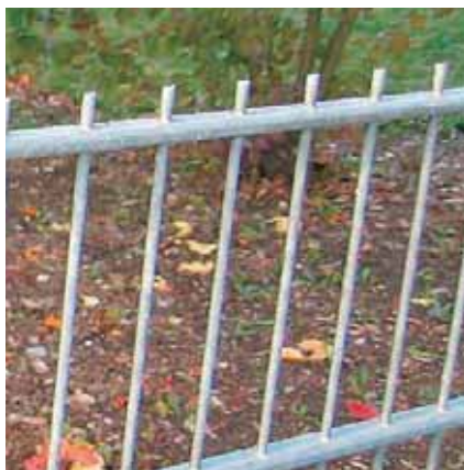
Bild 3 und 4: Stabgitterzaun ► Gefährdung durch hervorstehende, offene Enden
