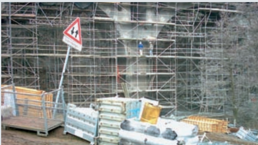
Einrüstung für Brückensanierung
