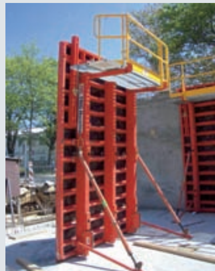
Laufsteg an Fertigteil Schalung
