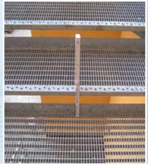
**Bild 3a + 3b:** Maximale lichte Weite für Krippenkinder an Treppen ohne Setzstufen und an Umwehungen: 8,9 cm
