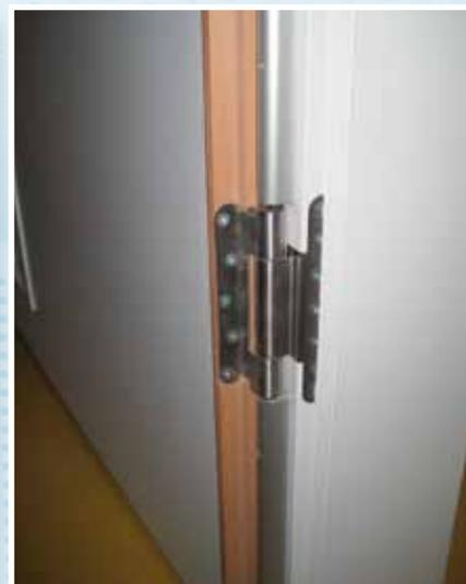
**Bilder 4 a–c:** Beispiele für Durchgreifschutz an Türen
