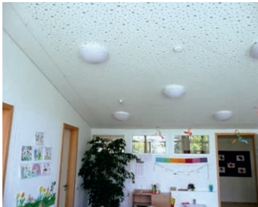
Lärminderung durch Einbau von Akustikdeckenverkleidungen
