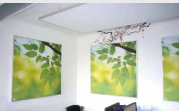
Abgehängtes Akustikelement sowie bedruckte Akustikbilder an den Wänden
