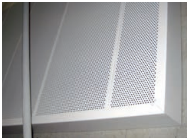
Bild 4: Akustikwandblechpaneele: Fläche 20 m², Wandabstand 100 mm, Lochanteil 16 – 20 %, Faservlies als Dämmstoff
