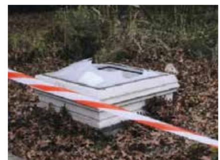
Bild 2: Defekte Lichtkuppel nach dem Unfall (Foto: Bankl, POM)
