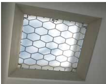
Bild 4: Innenliegende Absturzsicherung
