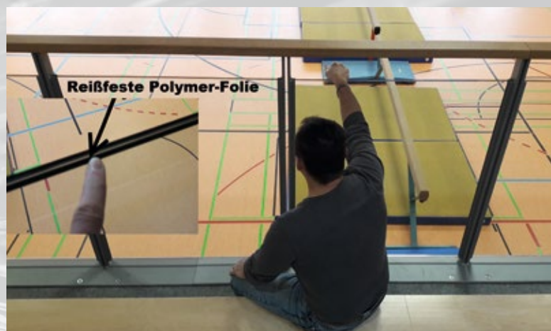
Abb. 8: VSG in absturzsichernder Ausführung (siehe auch Detailaufnahme der Folie) als Tribünenverglasung in einer Sporthalle. Die Glaskonstruktion ist gem. DIN 18008 zu bemessen.
