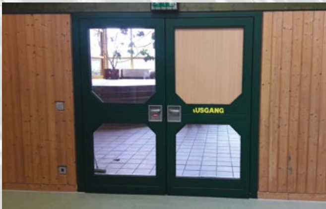
Abb. 1: Unfallsituation – komplett zerstörte obere Türverglasung. Mit Sicherheitsglas wären die Verletzungsfolgen gering gewesen.
