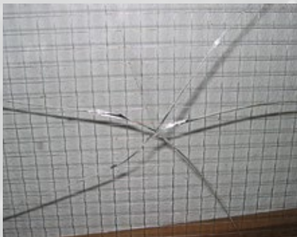
Abb. 1: Unfallsituation – komplett zerstörte obere Türverglasung. Mit Sicherheitsglas wären die Verletzungsfolgen gering gewesen.
