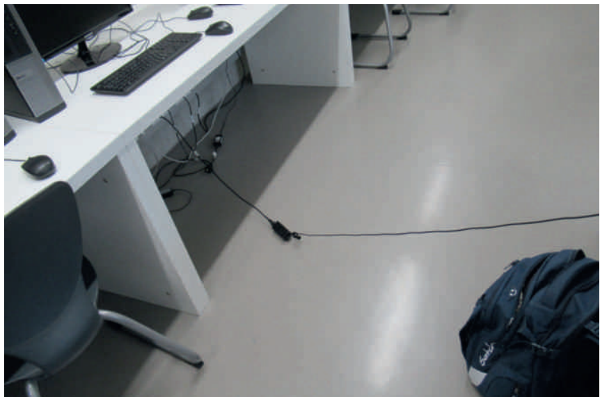
Abb. 3 und 4: „Kabelsalat“ in einem Klassenzimmer mit Gefahr der Quetschung des Kabels durch das Tischbein; unten: Über den Verkehrsweg verlegtes, in der Luft hängendes Netzteil, das der Laptop-Energieversorgung dient; zusätzliche Gefährdung durch Zugbelastung auf stromführende Teile.
