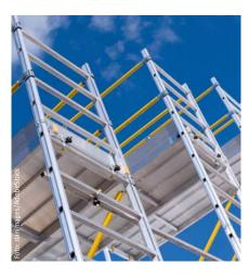
zungen, die ab einer in der Montageanleitung angegebenen Höhe montiert werden müssen. Wichtig ist auch, dass die Geländer, die später vor einem Absturz schützen sollen, vollständig und sicher angebracht werden.
