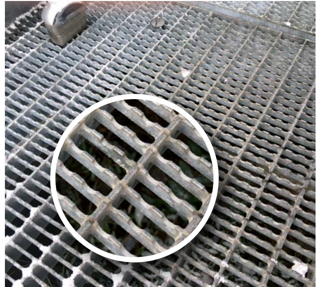
Detail – besonders trittsicherer Gitterrost mit guter Rutschfestigkeit und Maschenweite von 30/10 mm mit Halbrundausnehmungen bzw. Einkerbungen.
