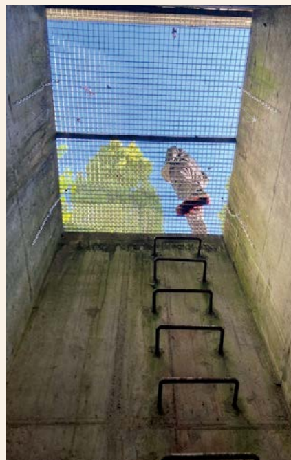
Der Blick von „unten“ zeigt die Situation mit nachgerüsteter Aushebesicherung der Roste.
