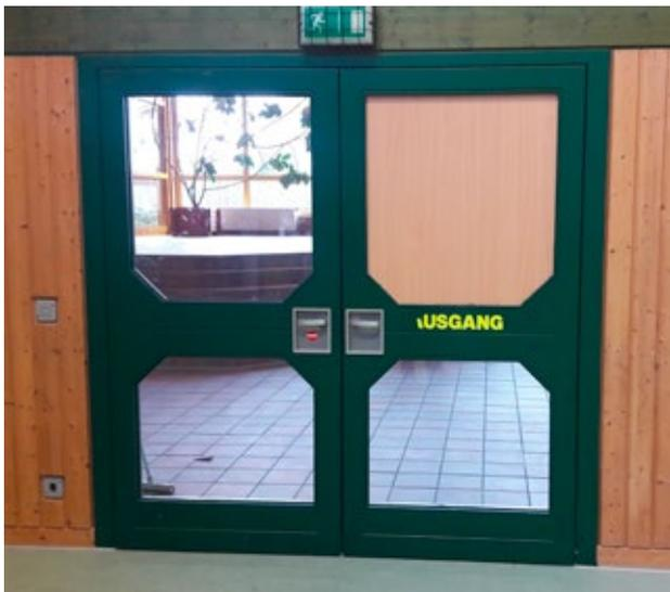
*Komplett zerstörte obere Türverglasung (rechts oben). Mit Sicherheitsglas wären die Verletzungsfolgen gering gewesen.*
