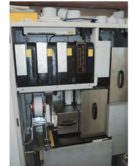
Befüllung des Banknotenautomaten von der Rückseite (Technikraum)
