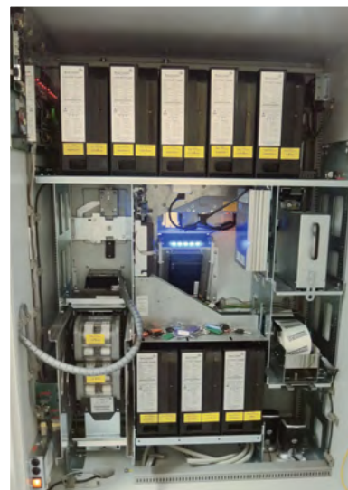
Öffnung der Rückseite des Bezahlautomaten im Technikraum
