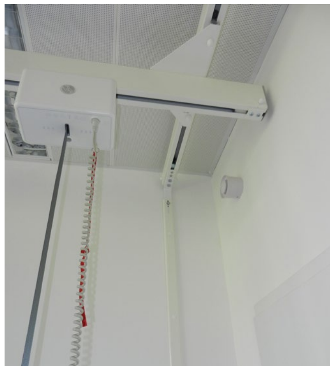
Bild 3: Portalmontage eines Patienten-Deckenlifters
