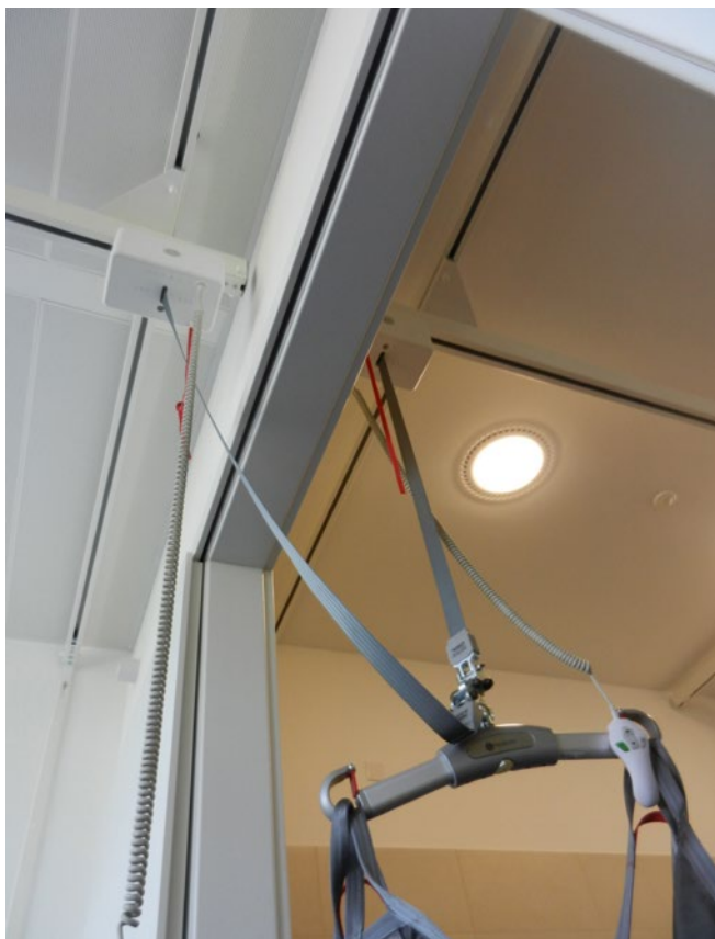
Bild 5: Deckenliftsystem mit Umhängemöglichkeit des Liftertuches am Türsturz
