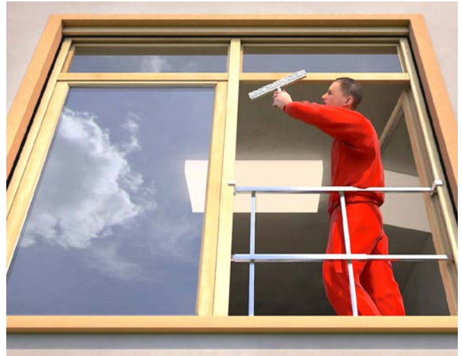
Abb. 3 Mobiles Schutzgeländer in Fensterrahmen
