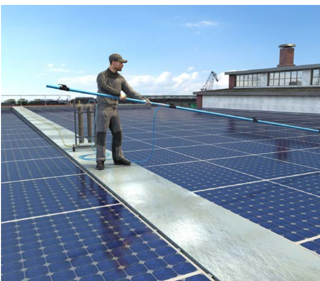
Abb. 16 Reinigung von Photovoltaikanlagen mit entmineralisiertem Wasser
