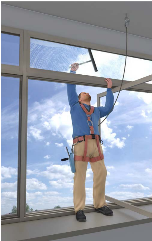
Abb. 1 Einsatz von PSAgA bei Fensterreinigung
