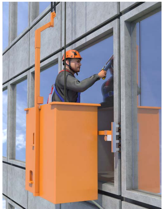
Abb. 62 Fassadenreinigung mit Fassadenbefahranlage
