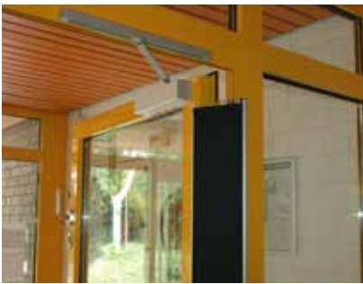
Vermeidung von Quetsch- und Scherstellen an einer Haupteingangstür durch das Anbringen von Klemmschutz an der Nebenschließkante
