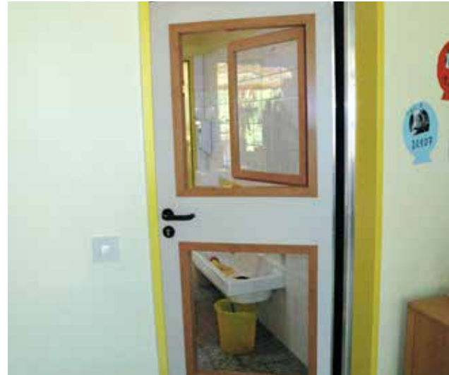
Beispiel: Die Durchsicht auf kleinere Kinder reduziert die Gefährdung durch aufschlagende Türen (hier die Tür vom Gruppenraum zum Sanitärbereich).
