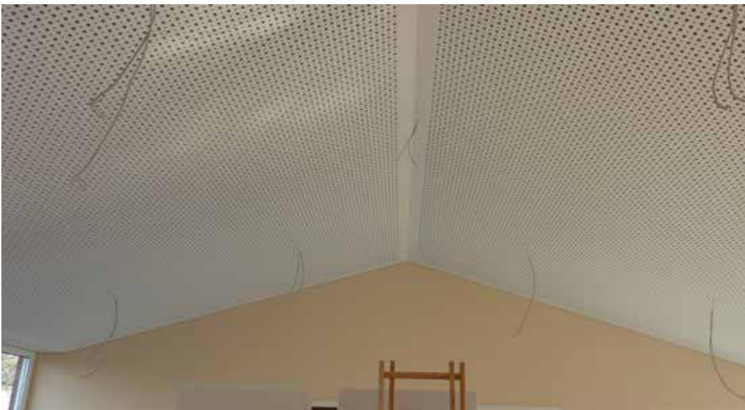
Beispiel für schallabsorbierendes Deckenmaterial in einer nachträglich raumakustisch sanierten Kindertageseinrichtung
