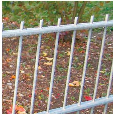
Bild 3 und 4: Stabgitterzaun ► Gefährdung durch hervorstehende, offene Enden
