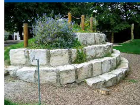
Bild 4: Sitzstufenanlage: max. Fallhöhen beachten; hervorstechende Kanten runden oder fasen; Sicherung gegen Hineinlaufen von oben! Spaltbreite max. 3 cm – hier verfugt – o.k.
