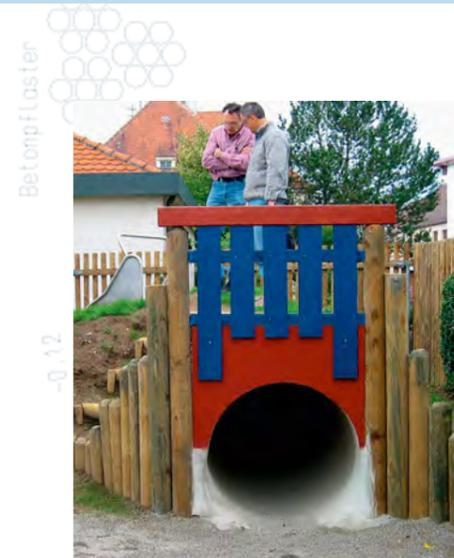
Bild 10: Kriechröhre – Bereich oberhalb der Röhre ist gegen Hineinlaufen/Absturz gesichert; Alle Kanten der Röhre sind gerundet bzw. gefast.
