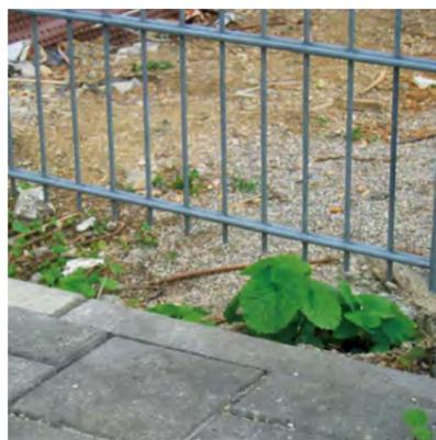
Bild 5: Stabgitterzaun ► keine Gefährdung, Enden stehen nach unten. Auf möglichst geringen Bodenabstand achten!
