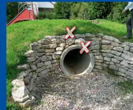
Bild 1: Kriechröhre – Begehbarer Bereich oberhalb des Ein-/Ausgangs hat keine Absturzsicherung; Scharfe Kanten an den Rohrenden runden oder fasen.
