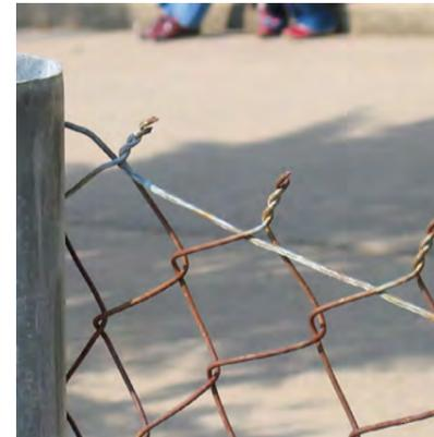
Bild 7: Maschendrahtzaun ► Gefährdung durch hervorgebogene, offene Enden
