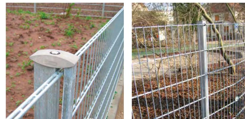
Bild 1 und 2: Stabgitterzaun ► keine Gefährdung, abgeschirmte Enden
