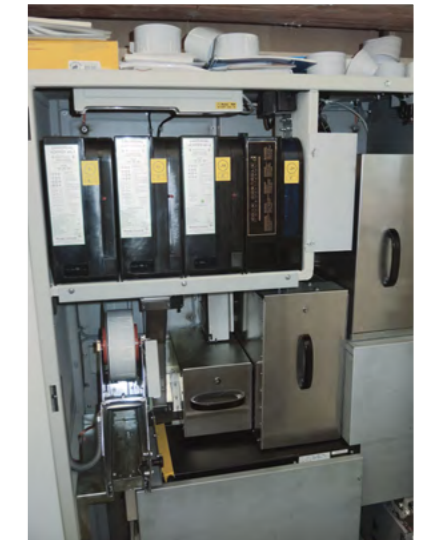
Befüllung des Banknotenautomaten von der Rückseite (Technikraum)
