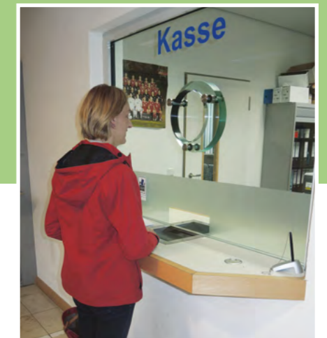
Durchschusshemmender Frontaufbau in Kasse Straßenverkehrsamt
