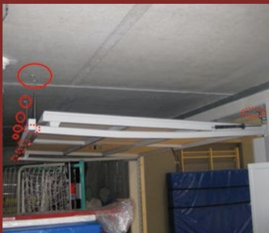
Gut! Die oberen Laufschienen sind in einwandfreiem Zustand. Die Aufhängung der Schienenkonstruktion wurde mit geeigneten und bauaufsichtlich zugelassenen Befestigungsmitteln in der massiven Betonwand befestigt. Somit ist dauerhaft sichergestellt, dass die Konstruktion sicher hält. Die spätere Kontrolle ist dadurch weniger aufwendig.
