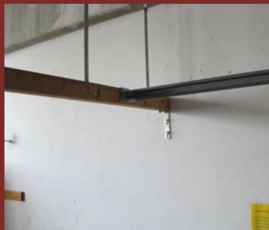
Die Sicherheit der Aufhängung bei diesem „älteren“ Tor ist offensichtlich fraglich. Hier muss geprüft werden, ob die statisch-konstruktive Sicherheit dauerhaft gewährleistet ist. Auch die Bemessung und Zulässigkeit der Schraubverbindungen der Wand- bzw. Deckenbefestigung muss hinterfragt werden und ist mit zu überprüfen.
