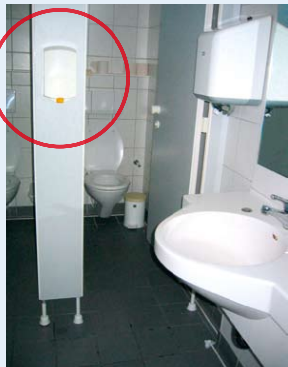
Rutschpartie auf dem Weg zur Toilette durch falsch angebrachte Seifenspender
