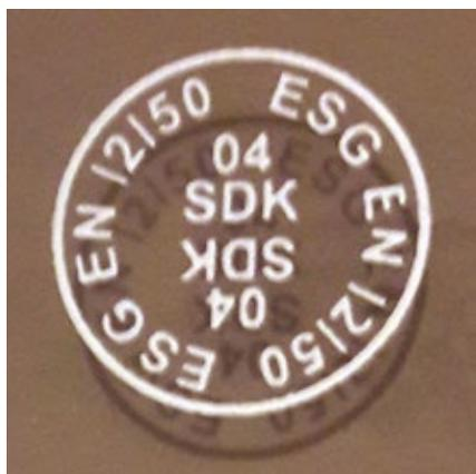
Abb. 2 – ESG-Kennzeichnungsbeispiel: hier DIN 12150; Weitere Erkennungsmerkmale von Sicherheitsglas sind Aufdrucke mit DIN 1249 sowie von Herstellern wie z. B. „Sekurit“.
