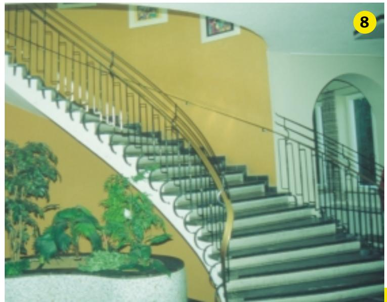
Dünne, seitlich versetzte Stäbe dienen gleichzeitig der Geländererhöhung und Sicherung gegen Rutschen.
