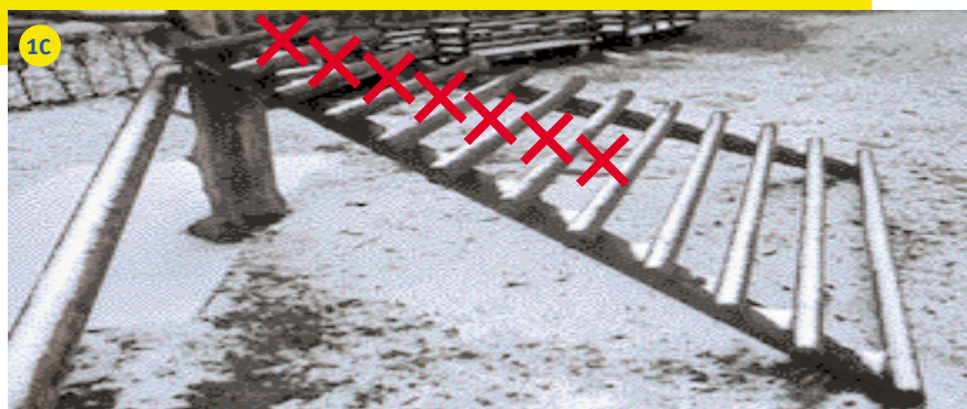
Abb. 1 a – c: Besonders gefährlich: Öffnungen zwischen 11 cm und 23 cm
