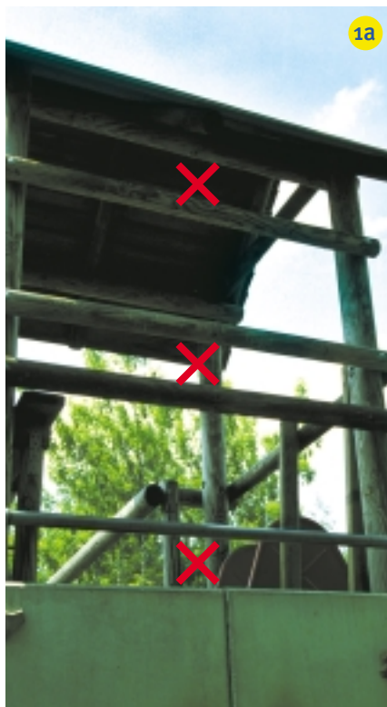
Abb. 1 a – c: Besonders gefährlich: Öffnungen zwischen 11 cm und 23 cm
