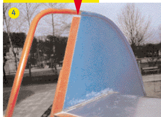
Abb. 4: Besonders gefährlich: Fangstellen für Kleidung an Rutschen
