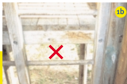
Abb. 1 a – c: Besonders gefährlich: Öffnungen zwischen 11 cm und 23 cm
