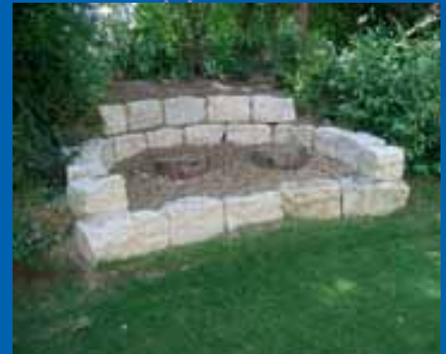
Bild 3: Sitzstufenanlage aus Natursteinen – gut in das vorhandene Gelände (Erdwall) einfügt.
