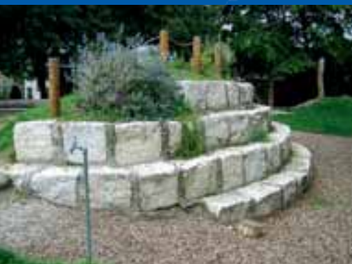
Bild 4: Sitzstufenanlage: max. Fallhöhen beachten; hervorstehende Kanten runden oder fassen; Sicherung gegen Hineinlaufen von oben! Spaltbreite max. 3 cm – hier verfugt – o.k.
