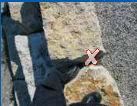
Bild 7: Sitzstufenanlage – offensichtliche Fangstelle für Füße, Fugenmaße müssen auf ca. 3 cm verringert werden.
