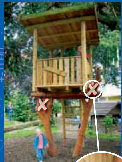
Bild 6a/b: Baumhaus – Versteckte gefährliche Kopf-Fangstellen! Durch Prüfkörper festgestellt.
