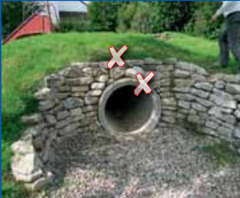
Bild 1: Kriechröhre – Begehbarer Bereich oberhalb des Ein-/Ausgangs hat keine Absturzsicherung; Scharfe Kanten an den Rohrenden runden oder fassen.
