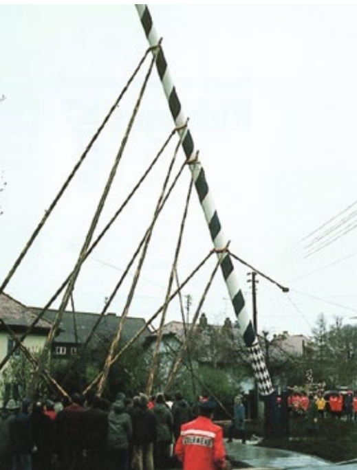
Aufrichten auf traditionelle Weise mit Hilfe von gestaffelt langen Stangen („Schwalben“).
