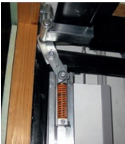
**Besonders sicher und bei Toren neuer Bauart Pflicht ist die Abfangsicherung gegen mögliches Abstürzen des Torblattes.**
