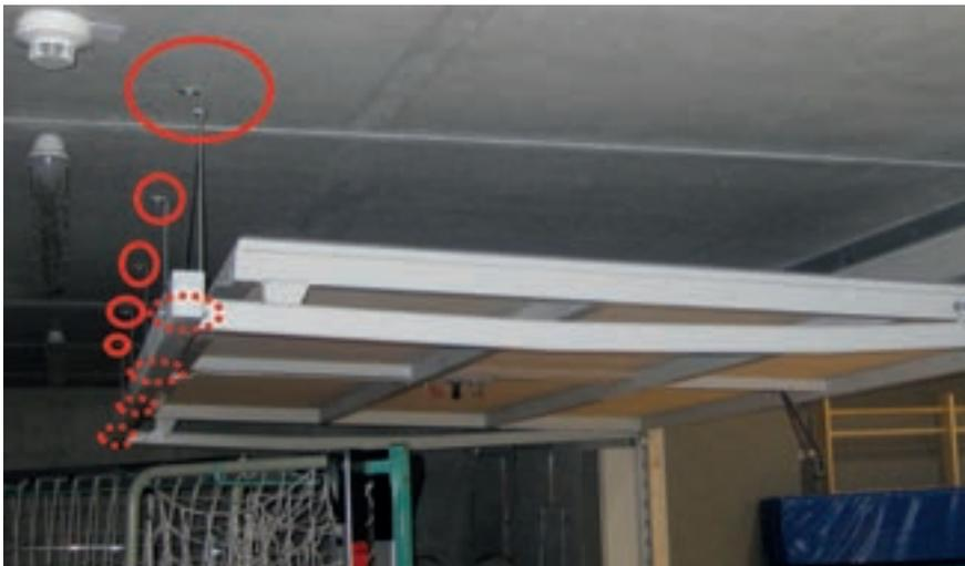
**Gut! Die oberen Laufschielen sind in einwandfreiem Zustand. Die Aufhängung der Schienenkonstruktion wurde mit geeigneten und bauaufsichtlich zugelassenen Befestigungsmitteln in der massiven Betonwand befestigt. Somit ist dauerhaft sichergestellt, dass die Konstruktion sicher hält. Die spätere Kontrolle ist somit weniger aufwendig.**
