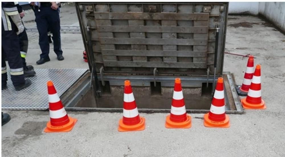
Abb. 2: Nach dem Unfall wurde der Einstiegsschacht (hier durch die Feuerwehr) provisorisch gesichert. Bei Fehlritten hätte auch hier, ohne entsprechende Sicherungsmaßnahmen, ein Absturz in den Schacht erfolgen können. (Foto: Polizei)
