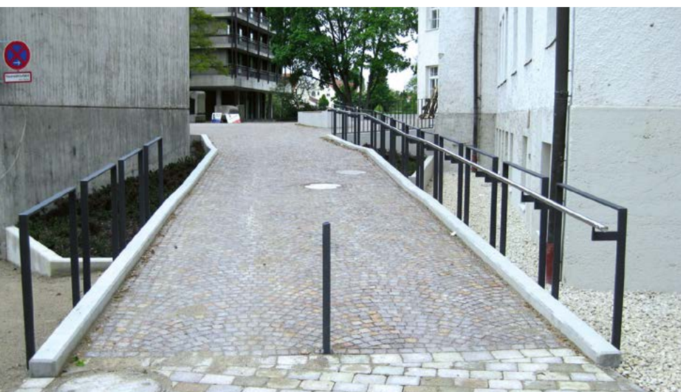
Sperrpfosten – Befahrung nur nach Absprache mit Hausmeister möglich.
