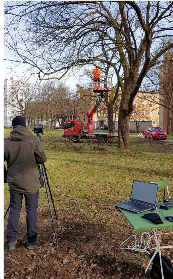
Aufbau der Messstation, hier bei der Analyse von Baumschneidearbeiten mit der Motorsäge im Korb eines Hubsteigers
